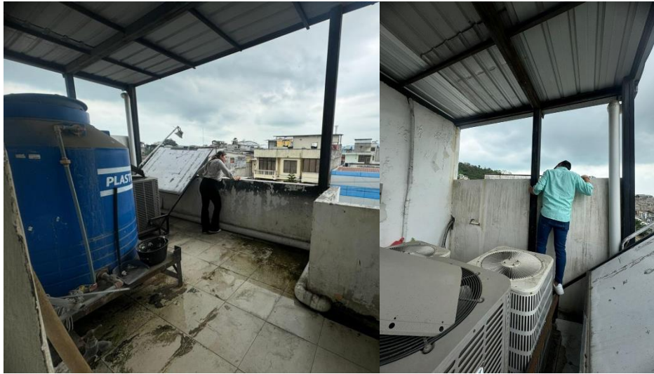
Anexo 5 Inspección y evaluación técnica
