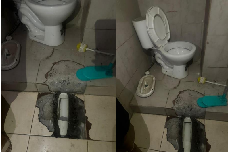
Anexo 1 Inspección baño afectado planta baja
