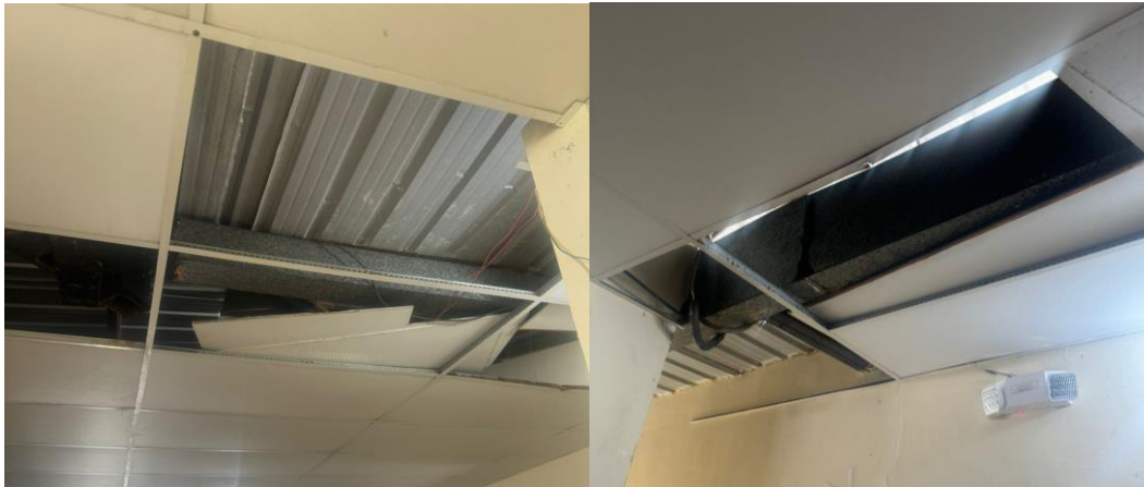
Fig. 15 Cielo raso - Segundo Piso
