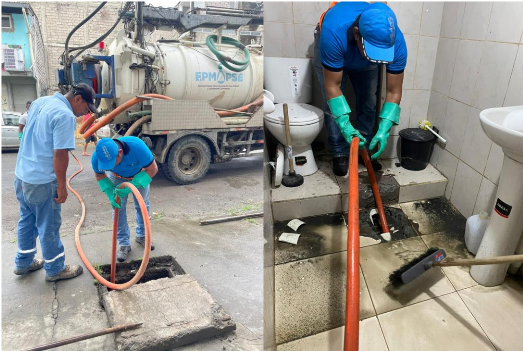
Fig. 8 Intervención Hidrocleaner – Unidades sanitarias – Caja de revisión
