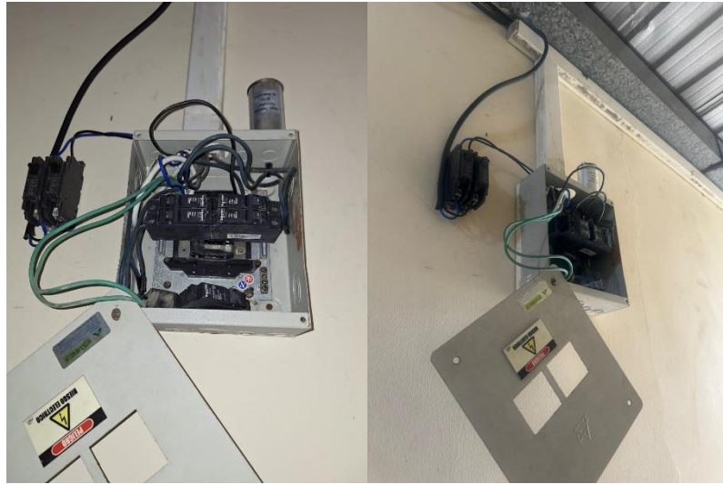
Anexo 3 Conexiones a cajas de suministro
