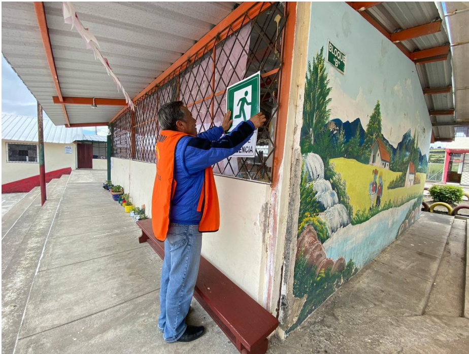
Ilustración 3. Colocación de Señalética
